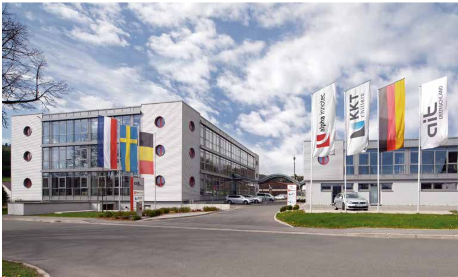
Zentrale alpha innotec in Kasendorf, Deutschland.
